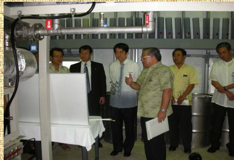
バイオエタノール生産設備視察 ②
