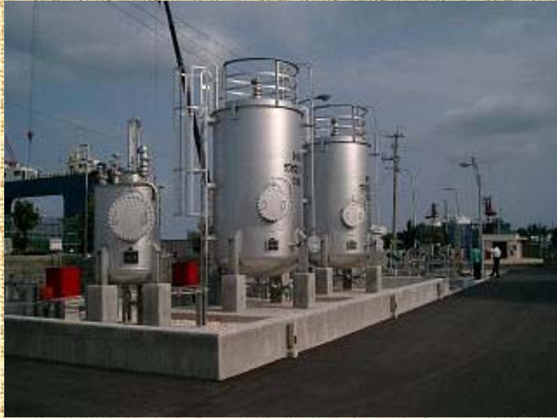
E3燃料製造設備全景
